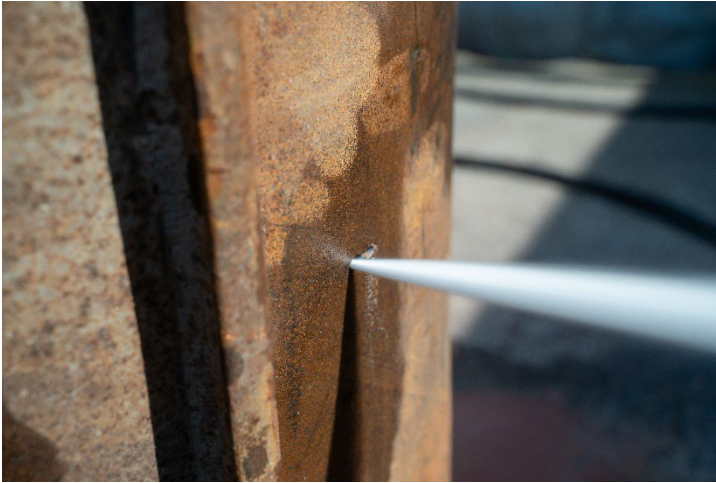
Caption: Abrassiivileikkauksesta ei synny kipinöitä, joka tekee siitä soveltuvan tehtäviin, joissa kipinöintiä on vältettävä. Leikkausvoima syntyy veteen sekoitetun abrassiivimateriaalin avulla. Alt-text: Abrassiivileikkaus seinän läpi
